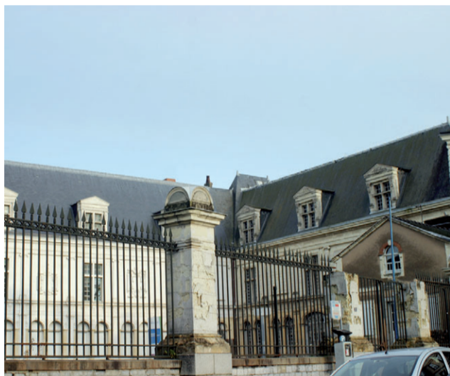
L'aile sud (ex-salle des assises du palais de justice) : « le choix de la municipalité est d'en faire une salle pour les associations qui serait doublée d'une seconde salle sous la charpente pour des répétitions et des conférences. Les travaux de restauration commenceront cette année. Ils représenteront un montant de 1,5 million d'euros. »
