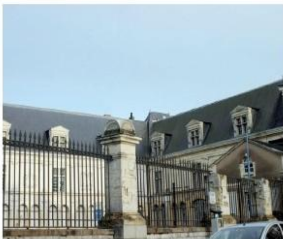
L'aile sud (ex-salle des assises du palais de justice) : « le choix de la municipalité est d'en faire une salle pour les associations qui serait doublée d'une seconde salle sous la charpente pour des répétitions et des conférences. Les travaux de restauration commenceront cette année. Ils représenteront un montant de 1,5 million d'euros. »
