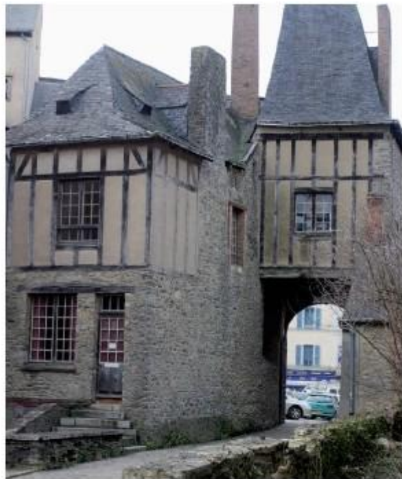
La maison Brilland : « des crédits ont été obtenus pour installer la direction des affaires culturelles. L'appel d'offres et les travaux démarrent dès cette année. »
