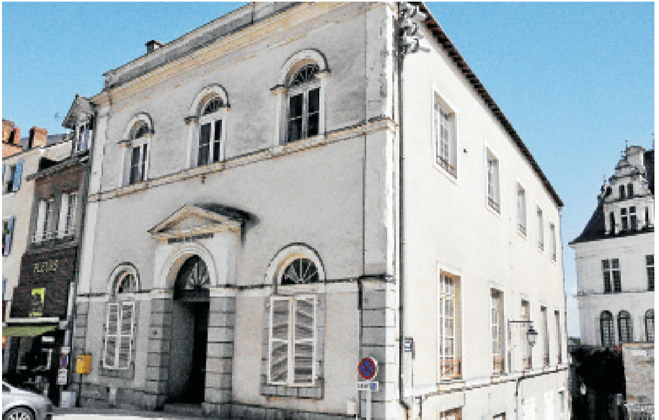
L'ancien tribunal de commerce de Laval va connaître des travaux importants. Un an de travail est prévu.
