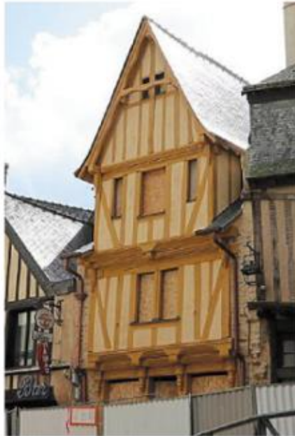
Le chantier de réhabilitation d'une des maisons à pans de bois du Vieux-Laval touche à sa fin. L'échafaudage devant l'édifice construit en 1503 a été retiré.
