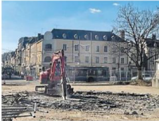
Place du 11-Novembre, la fontaine construite en 1976 a été démontée pour laisser place aux fouilles archéologiques à venir. | PHOTO : OUEST-FRANCE
